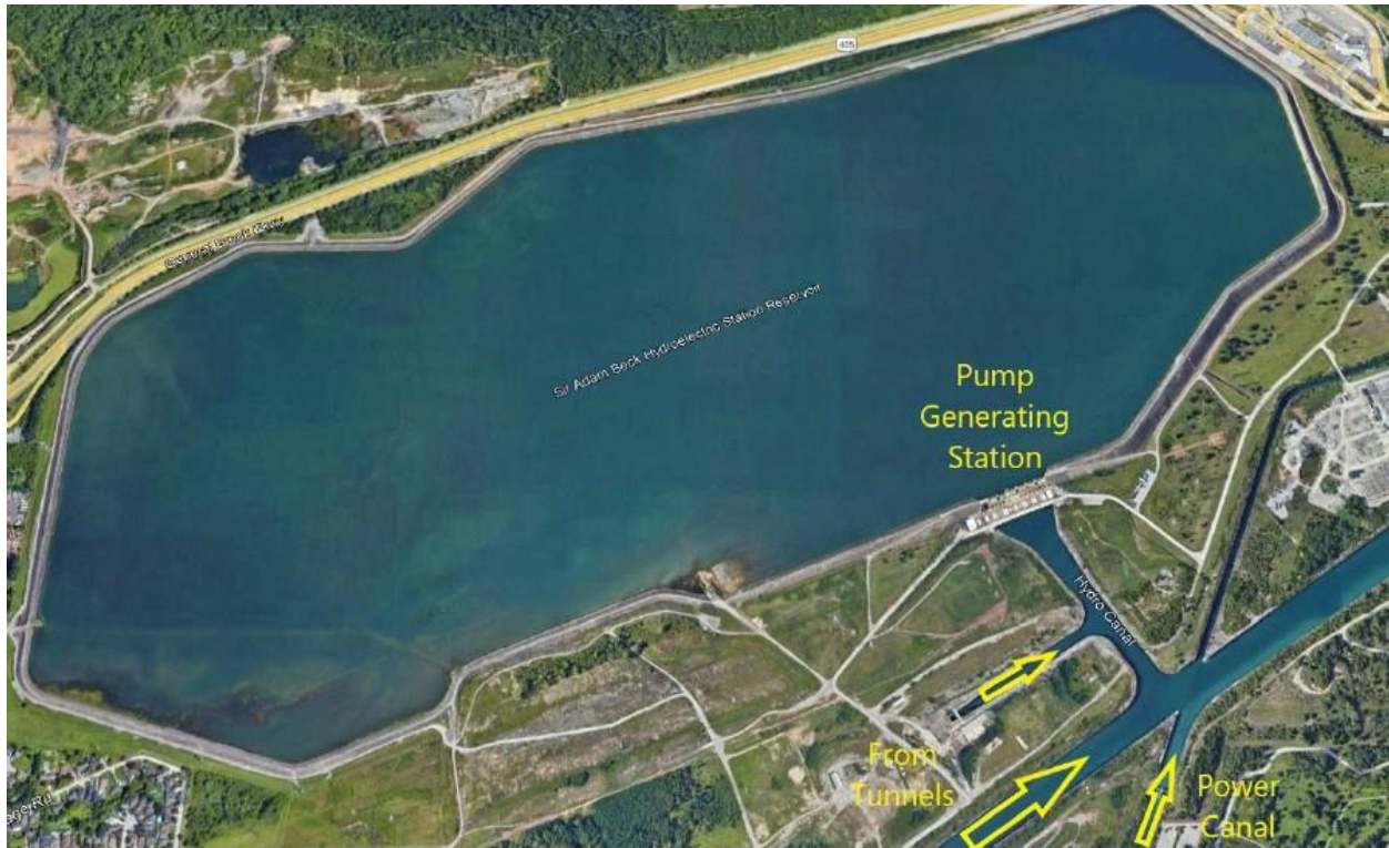
Figure 4 Centrale de pompage Sir Adam Beck à Niagara Falls, en Ontario
