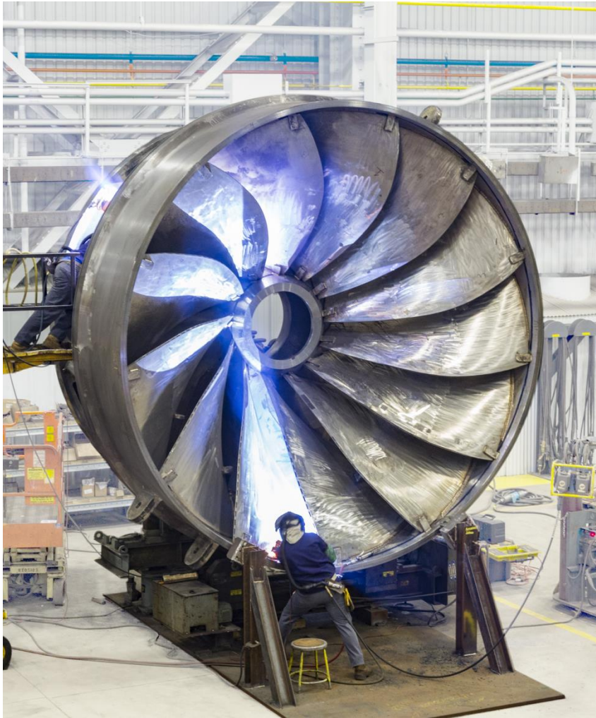
Une turbine de centrale hydroélectrique en réparation. Cette turbine est mue par un débit d'eau pouvant être rapidement modulé, ce qui la rend apte à fournir certains services réseau.
