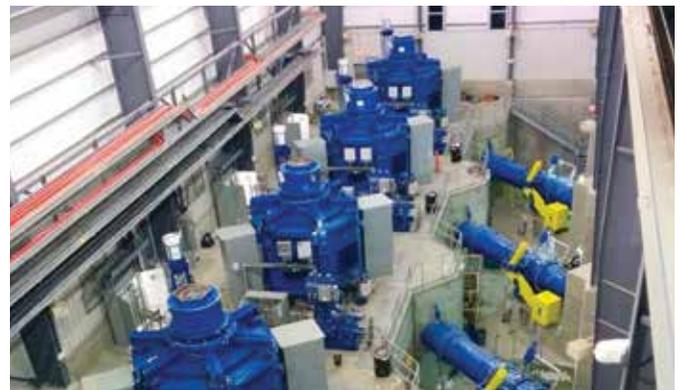
*Quatre turbines Pelton à arbre vertical à six injecteurs*
